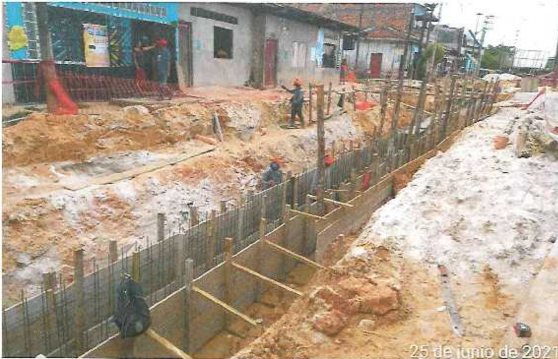
FOTOGRAFÍA 10: CONEXIÓN DE SISTEMA DE ALCANTARILLAS EN LA INTERCEPCION DE LA CALLE 26 DE MAYO Y CALLE URARINAS
