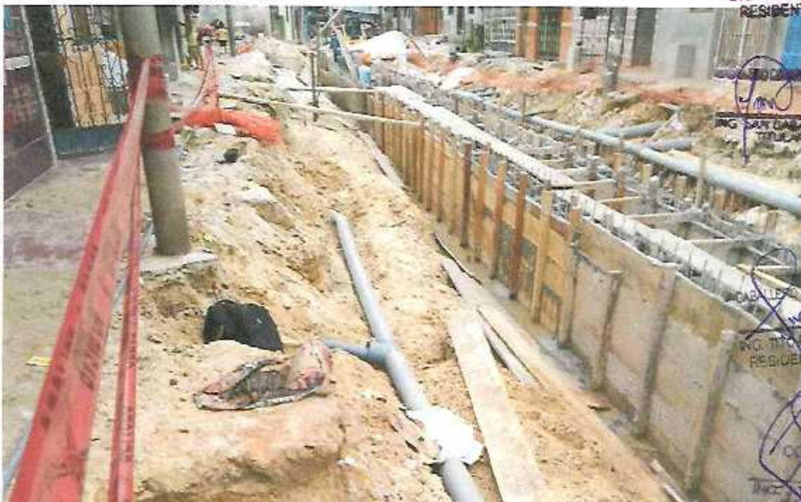
FOTOGRAFÍA 08: CONEXIONES AUXILIARES CON TUBO DE 6" EN LA CALLE 4 DE SETIEMBRE
