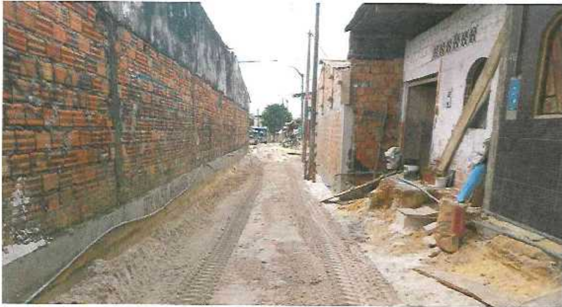
FOTOGRAFÍA 17: RELLENO EN EL PASAJE PABLO CHAVEZ A NIVEL DE SOBRE EXCAVACION
