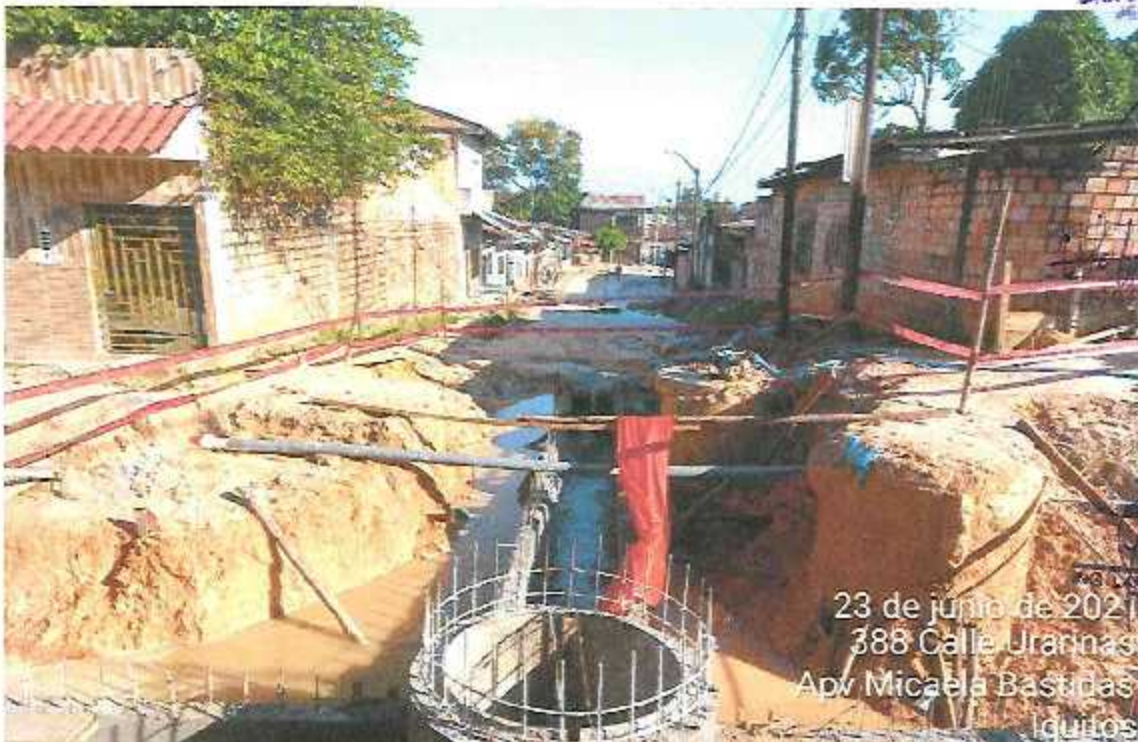
FOTOGRAFÍA 06: BUZON EN LA INTERCEPCION CALLE URARINAS CON PASAJE SECOYA
