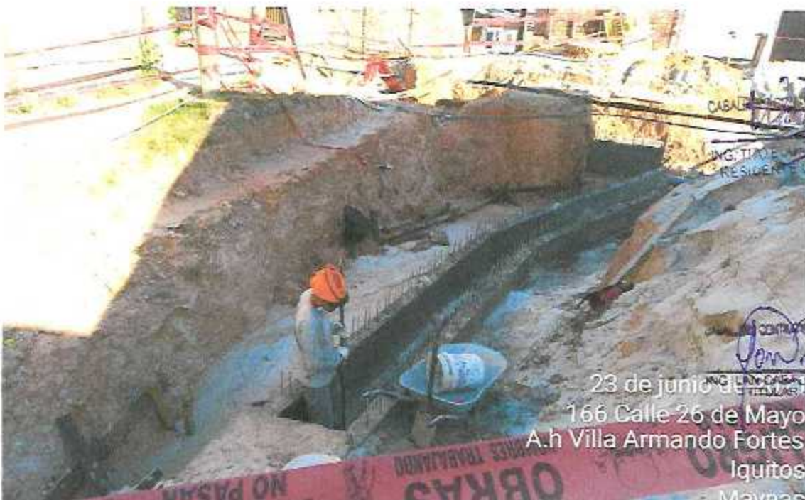
FOTOGRAFÍA 10: CONEXIÓN DE SISTEMA DE ALCANTARILLAS EN LA INTERCEPCION DE LA CALLE 26 DE MAYO Y CALLE URARINAS
