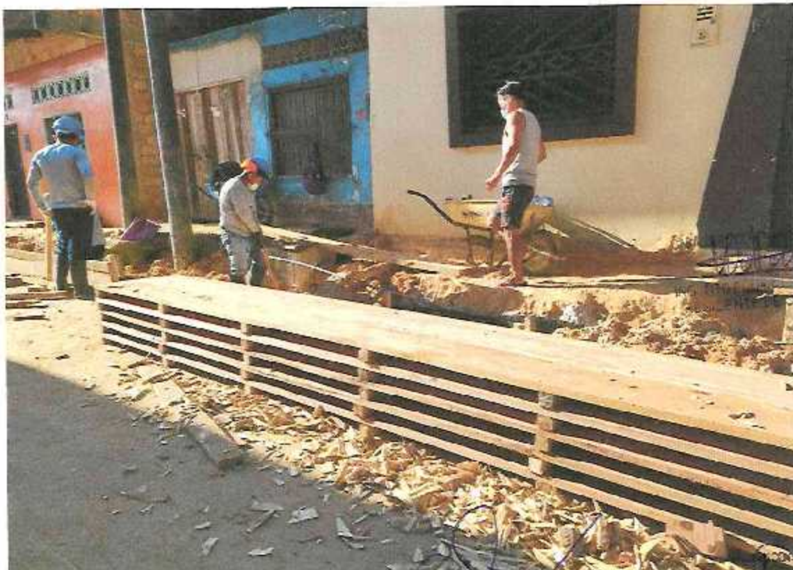
FOTOGRAFÍA 20: HABILITACION DE MADERA PARA ENCOFRADO DE LOSA DE PAVIMENTO
