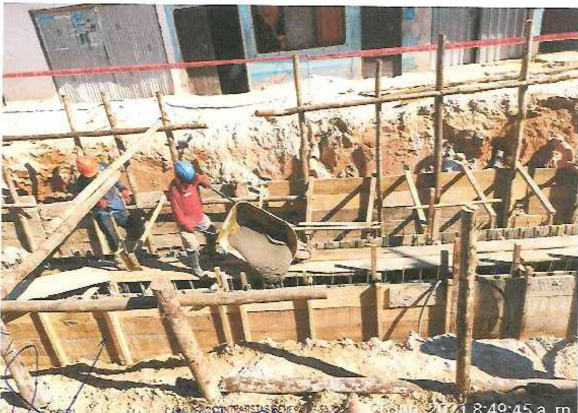
FOTOGRAFÍA 18: VACIADO DE CANAL EN LA CALLE URARINAS
